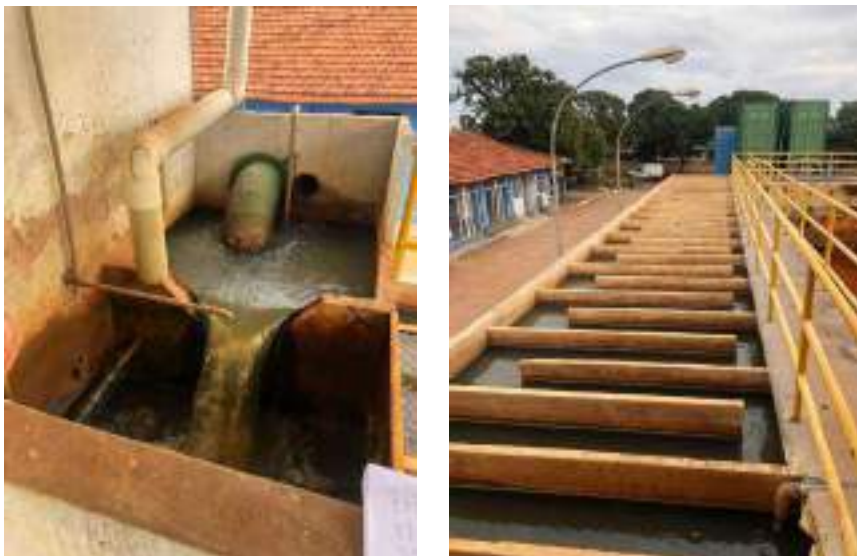
Figura 33: Chegada de água bruta na ETA-1
