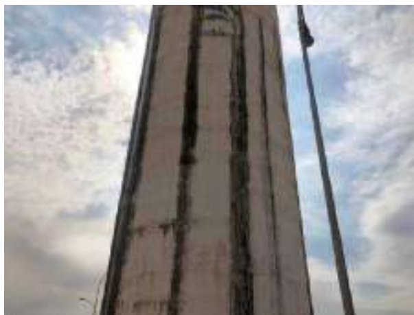
Figura 48: Vista dos problemas construtivos e vazamentos verificados na estrutura do Reservatório Elevado da ETA-2
