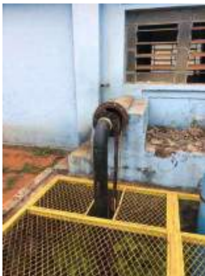
Figura 20: Vista da tubulação de recalque de uma das bombas submersíveis
