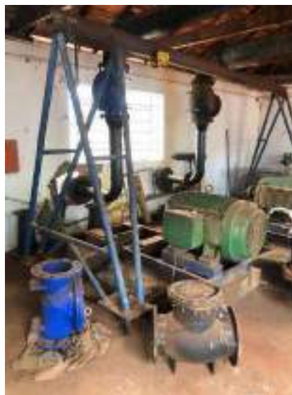
Figura 21: Vista dos motores dos 2 conjuntos motobombas de eixo horizontal desativados
