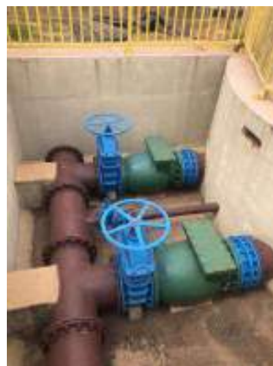
Figura 71: Detalhe da tubulação de recalque da EEE Final
