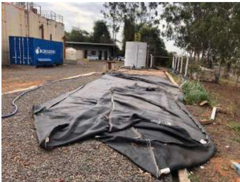
Figura 82: Vista do Geobag utilizado para desaguamento de lodo resultante da ECTE Córrego dos Pretos
