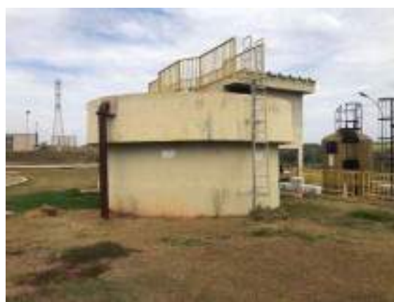
Figura 93: Adensador de Lodo e Casa de Desidratação do lodo, ao fundo
