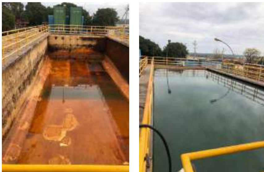
Figura 35: Decantadores da ETA-1
