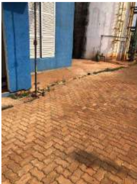
Figura 45: Detalhe do recalque do terreno no entorno das unidades
