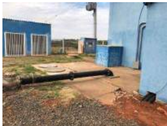
Figura 26: Entrada da tubulação de recalque do Poço Profundo PP-01 no poço de sucção da Estação Elevatória
