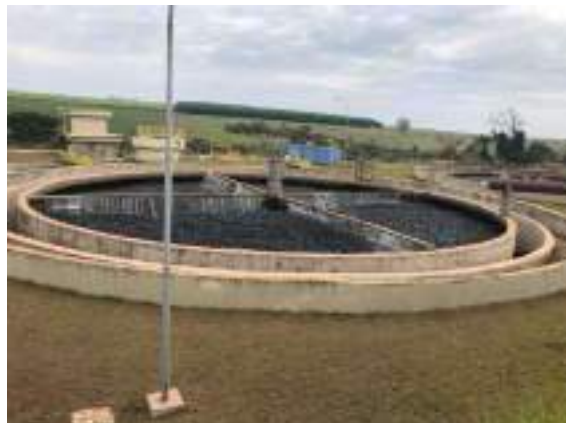
Figura 91: Filtro Biológico Anaeróbio
