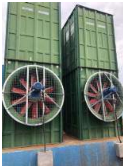
Figura 39: Torres de resfriamento da ETA-1
