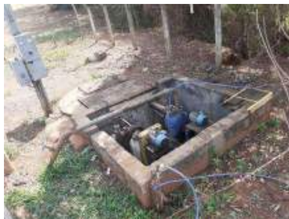
Figura 61: Conjuntos motobombas da EEE do Tropical
