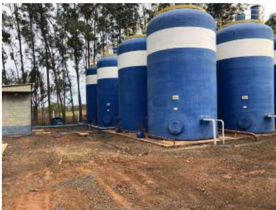
Figura 81: Vista dos módulos UASB e FAS da ECTE Córrego dos Pretos
