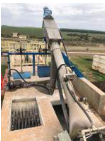
Figura 88: Sistema de Gradeamento
